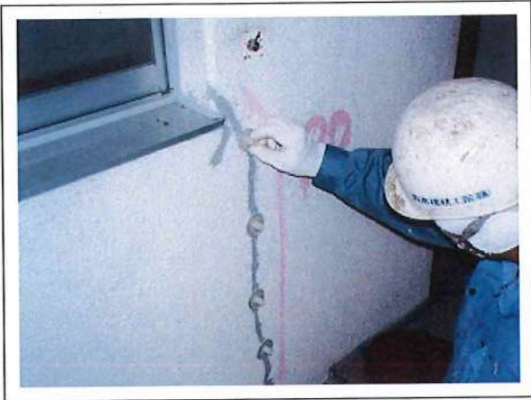
座金の取り付けと樹脂漏れ防止のコーキング
