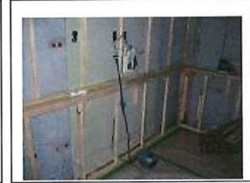
電気配線工事
