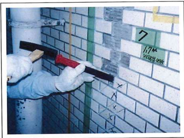
目地にカッターを入れた後にタイルを撤去
