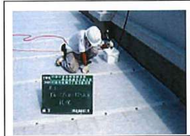
屋上防水工事
