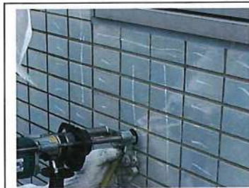
外壁補修工事
