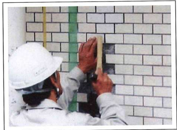
クラックに樹脂を注入後タイルを張替え
