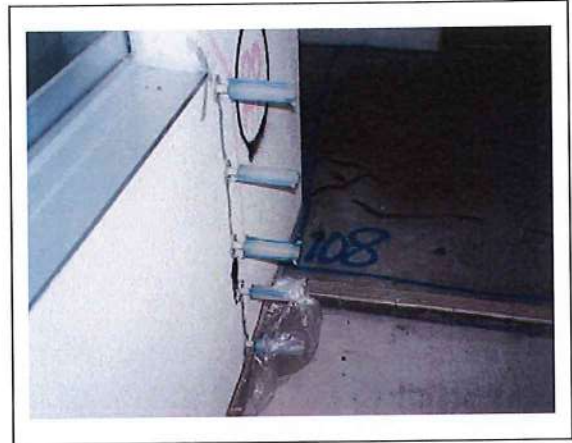
エポキシ樹脂を低圧注入
