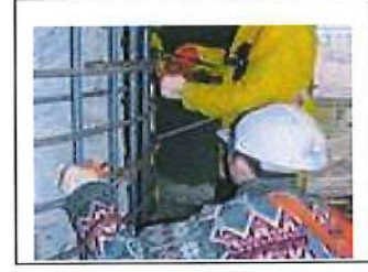
耐震補強工事
