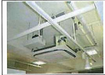
空調・ダクト取付工事
