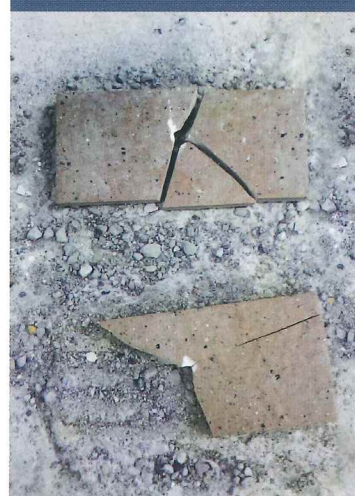
振動ドリル使用時の 穴あけ
